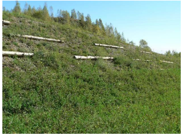
fig. 8 - Sistemazione con palizzate vive sotto il piazzale sommitale
