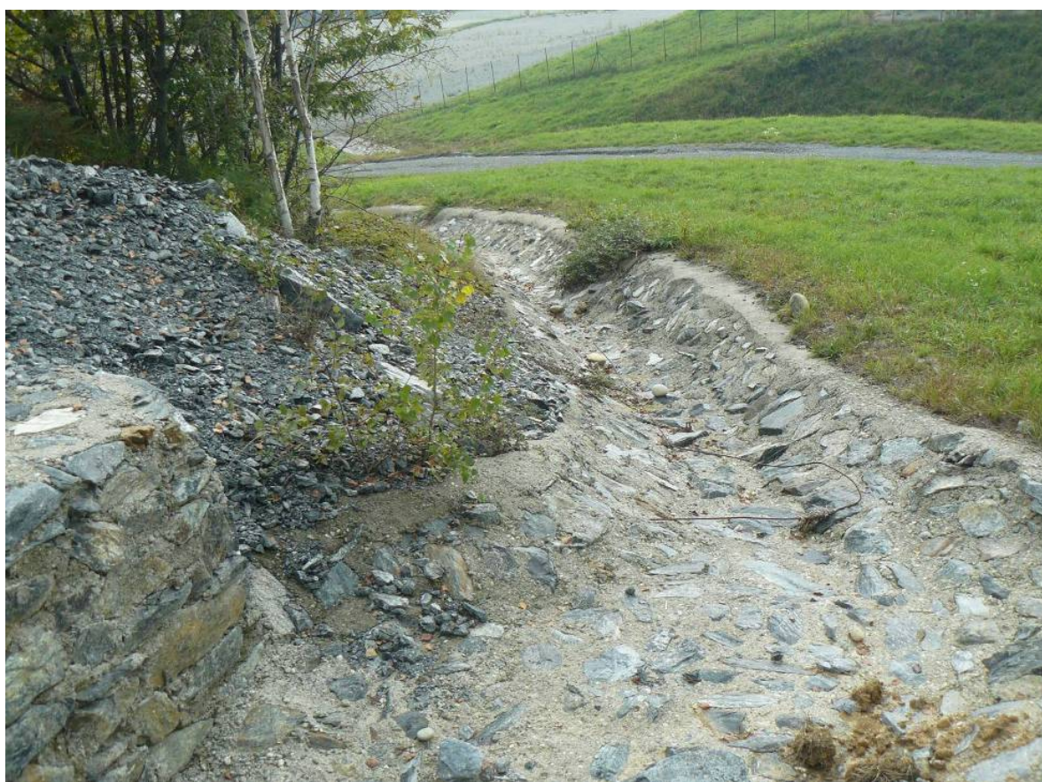
fig. 13 - Canaletta in pietrame cementato realizzata nella zona a est dell'area stabilimenti (versante Balangero)
