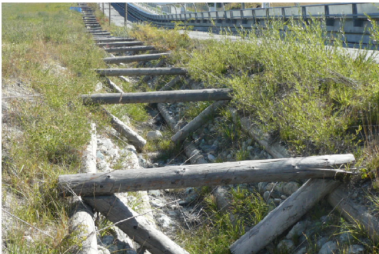
fig. 12 - Cunettone in legname e pietrame da utilizzarsi nella sistemazione dei tratti più acclivi o con spinte di scarpata
