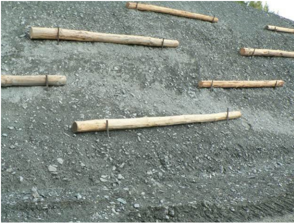
fig. 8 - Sistemazione con palizzate vive sotto il piazzale sommitale
