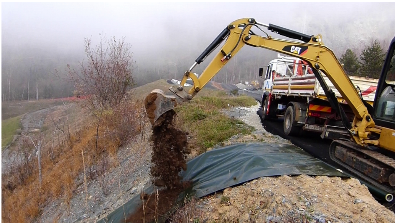
fig. 7 - Sistema di spandimento di substrato fertile su scarpata mediante teli
