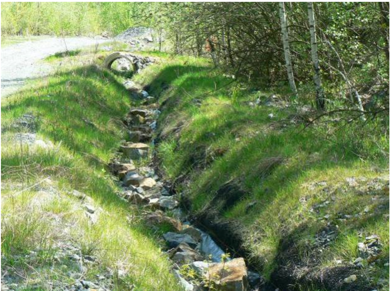
fig. 10 - Canalette rivegetate con telo impermeabile e geostuoia grimpante in PP (versante Fandaglia)
