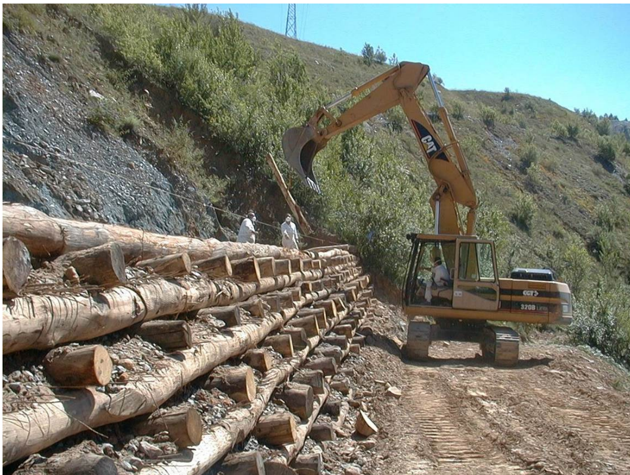
fig. 9 - Esecuzione di palificate di sostegno a doppia parete presso il versante Balangero
